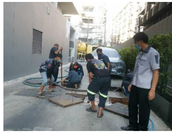
การสูบตะกอนจากระบบบำบัดน้ำเสีย (ต่อ)
