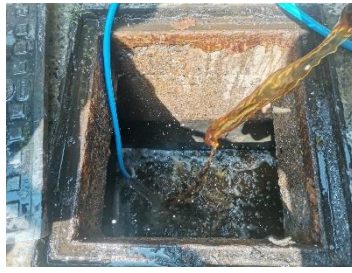
การสูบตะกอนจากระบบบำบัดน้ำเสีย
