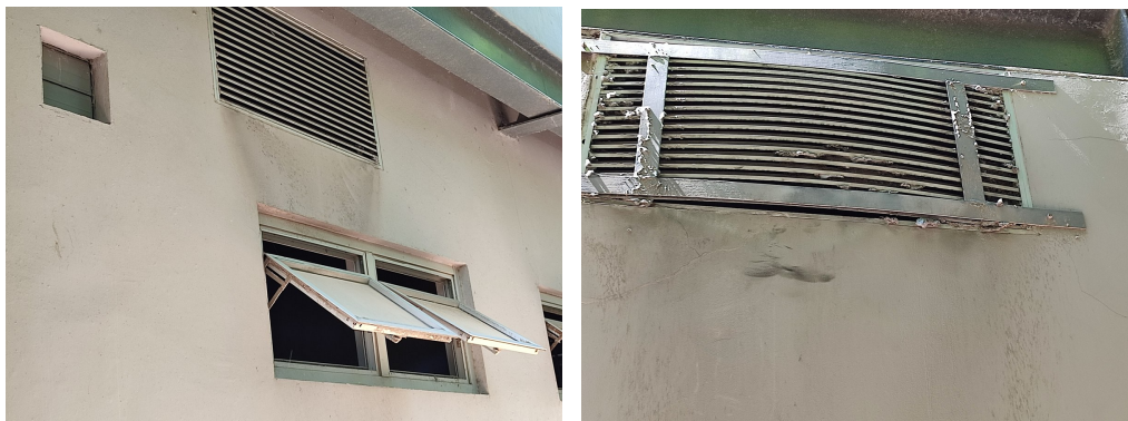
ภาพที่ 4-19 ช่องเปิดระบายอากาศของอาคาร และพัดลมระบายอากาศ
