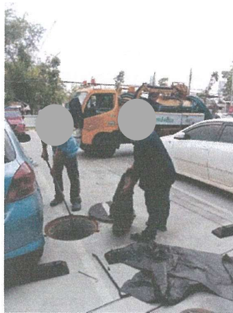
รูปภาพที่ 2.54 การขุดลอกตะกอนในท่อระบายน้ำ
