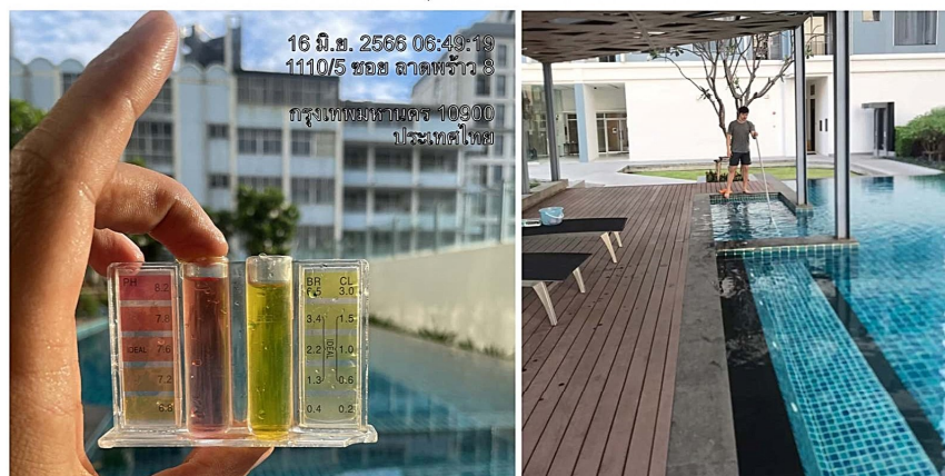
ภาพที่ 3-12 จดบันทึกค่า pH และ Residual Chlorine เป็นประจำทุกวัน , สระว่ายน้ำและทางเดิน
