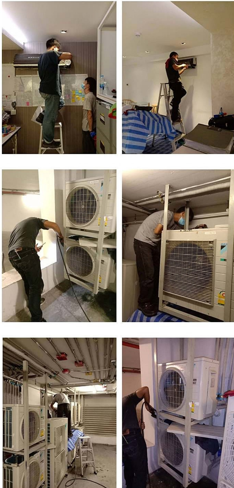
ภาพที่ 3-32 ล้างทำความสะอาดเครื่องปรับอากาศ
