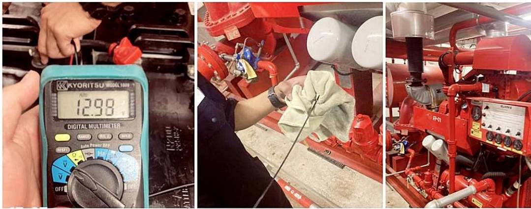
ภาพที่ 3-37 ตรวจสอบซ่อมบำรุงระบบ Fire Pump
