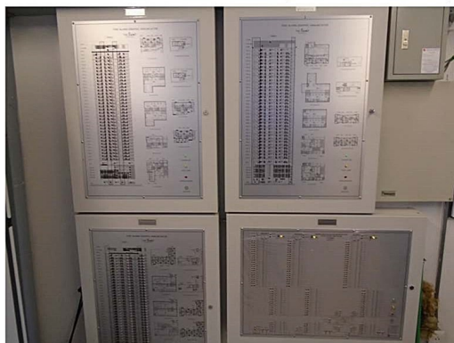
ภาพที่ 3-26 ห้องควบคุมสัญญาณอุปกรณ์แจ้งเหตุเพลิงไหม้
