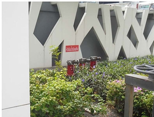
ภาพที่ 3-24 หัวรับน้ำดับเพลิงจากภายนอกของโครงการ
