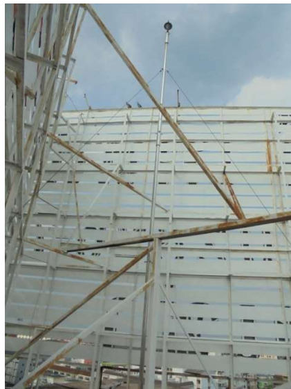
ภาพที่ 4-23 เสาไฟฟ้าและตอระบบลงดิน
