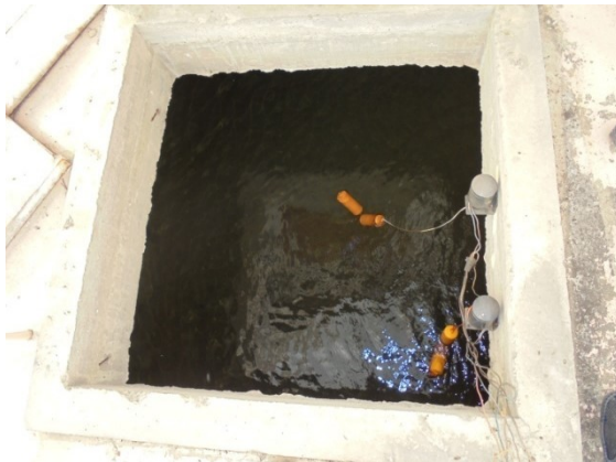
ภาพที่ 4-5 ถังสำรองน้ำใต้ดิน เปลี่ยนอุปกรณ์ข้อต่อต่างๆ และอยู่ในสภาพดี ไม่มีรั่วซึม และถังสำรองน้ำชั้นดาดฟ้า
