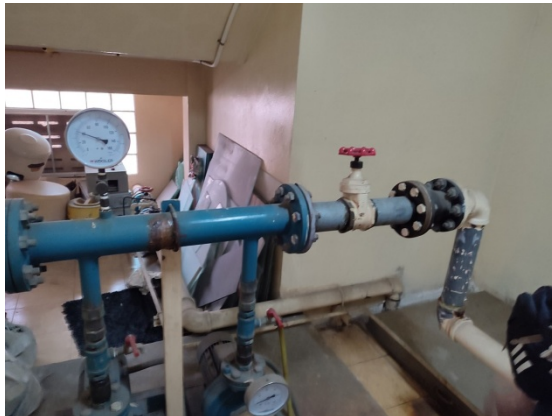
ภาพที่ 4-7 ระบบส่งจ่ายน้ำประปาไม่พบรอยรั่วซึม
