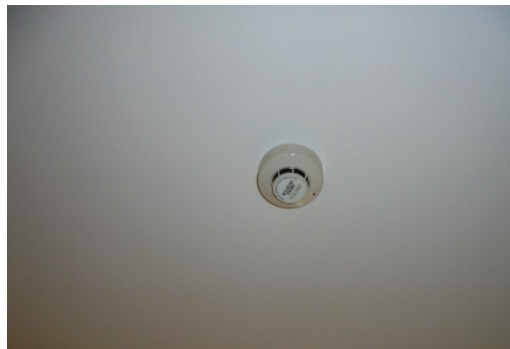
ภาพที่ 4-20 Smoke Detector
