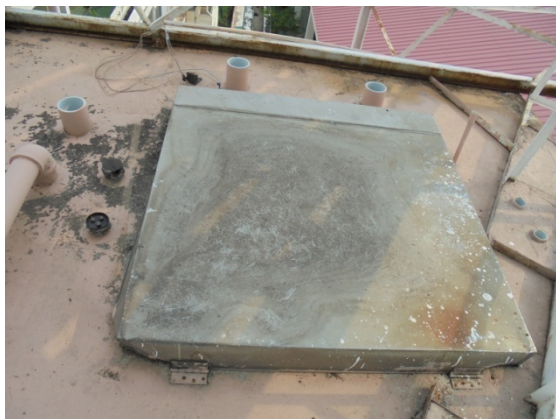
ภาพที่ 4-5 ถังสำรองน้ำใต้ดิน เปลี่ยนอุปกรณ์ข้อต่อต่างๆ และอยู่ในสภาพดี ไม่มีรั่วซึม และถังสำรองน้ำชั้นดาดฟ้า
