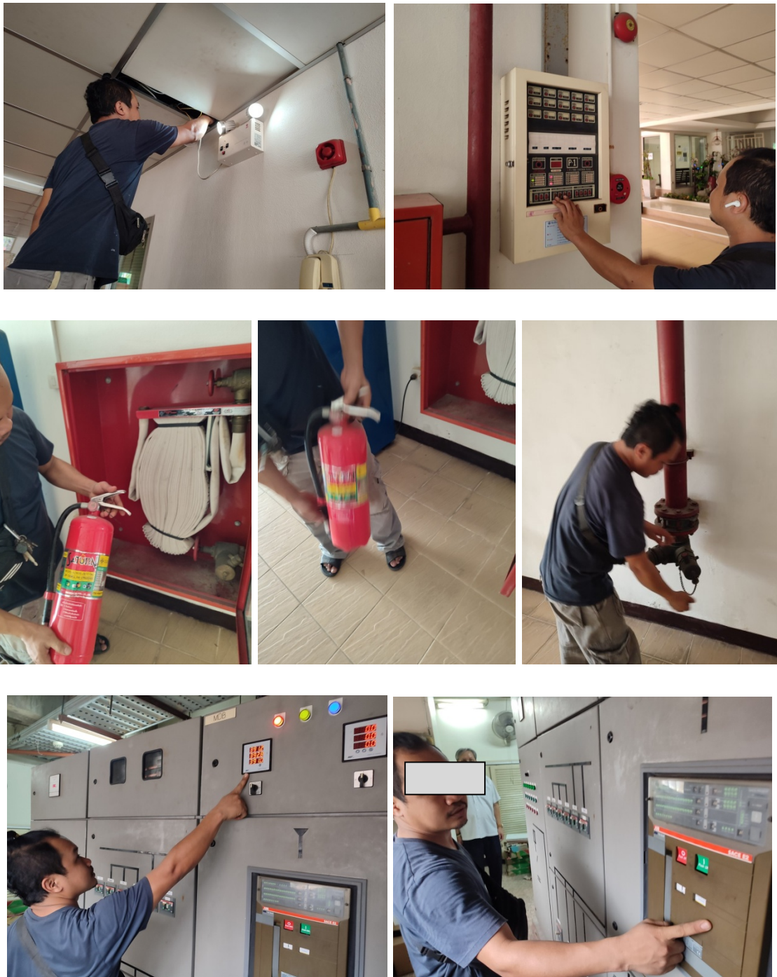
ภาพที่ 4-34 ตรวจสอบอุปกรณ์ป้องกันและเตือนอัคคีภัย และห้องเครื่องไฟฟ้าของอาคาร อยู่ในสภาพดีพร้อมใช้งาน
