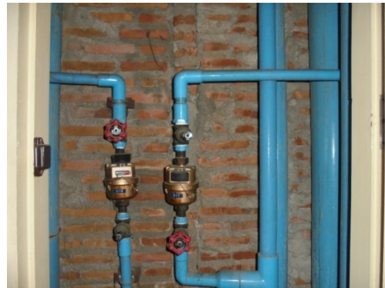
ภาพที่ 4-7 ระบบส่งจ่ายน้ำประปาไม่พบรอยรั่วซึม
