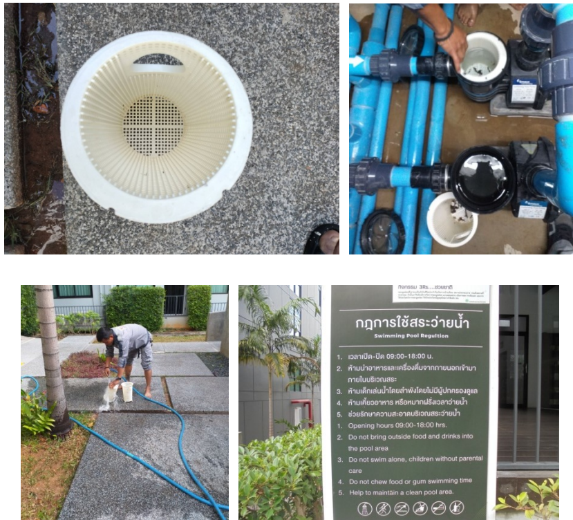
ภาพที่ 4-27 สระว่ายน้ำ อุปกรณ์ทำความสะอาด เว้นทางเดินริมสระไม่ต่ำกว่า 1.20 เมตร และป้ายระเบียบการใช้สระว่ายน้ำ
