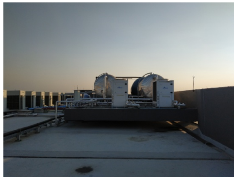
ภาพที่ 5-13 ถังสำรองน้ำใต้ดินและถังสำรองน้ำขึ้นดาดฟ้า
