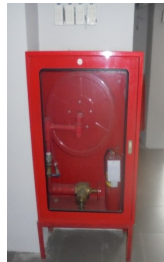
ภาพที่ 5-27 อุปกรณ์ดับเพลิง หัวกระจายน้ำดับเพลิงอัตโนมัติ ระบบท่อเย็นและตู้เก็บสายฉีดน้ำดับเพลิง
