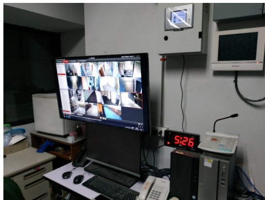
ภาพที่ 5-30 ระบบโทรทัศน์วงจรปิดของโครงการ
