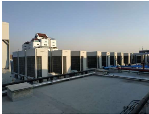
ภาพที่ 5-3 ระบบปรับอากาศแบบ CDU
