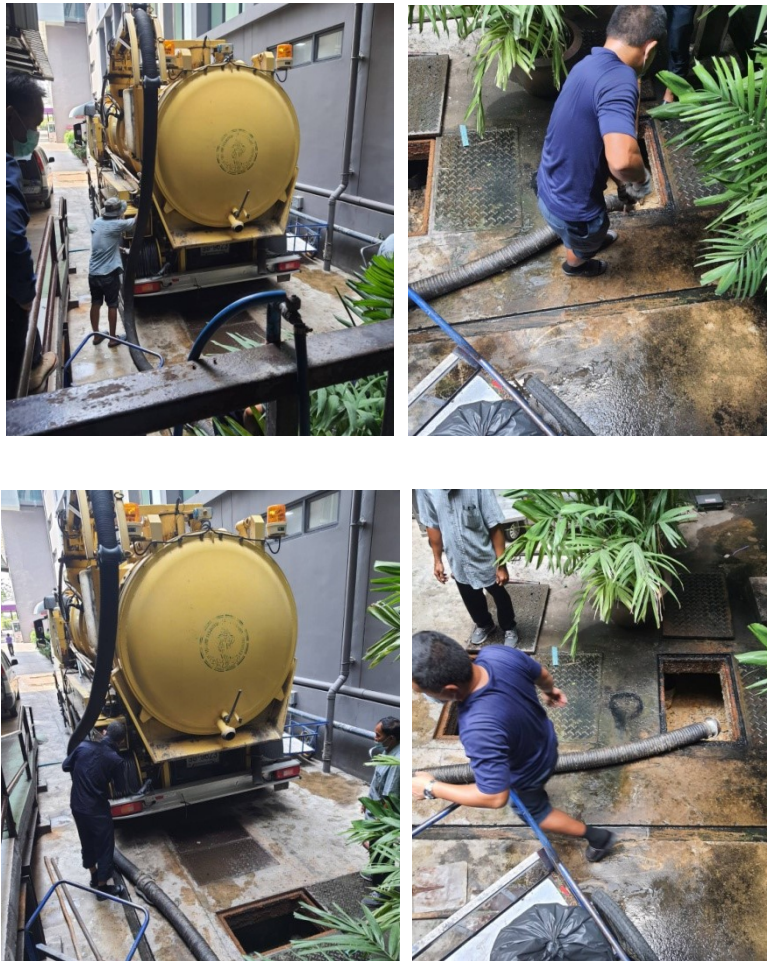
ภาพที่ 5-31 ดูดตะกอนที่บ่อเก็บตะกอนของระบบบำบัดน้ำเสีย
