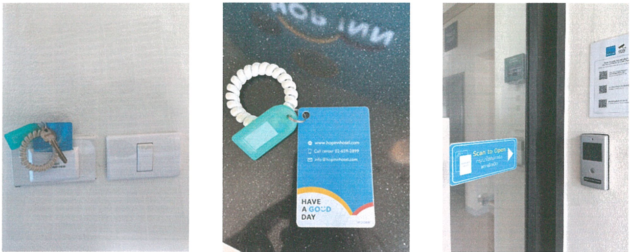
รูปภาพที่ 2.18 ระบบคีย์การ์ด ควบคุมการเปิด-ปิด ภายในห้องพัก
