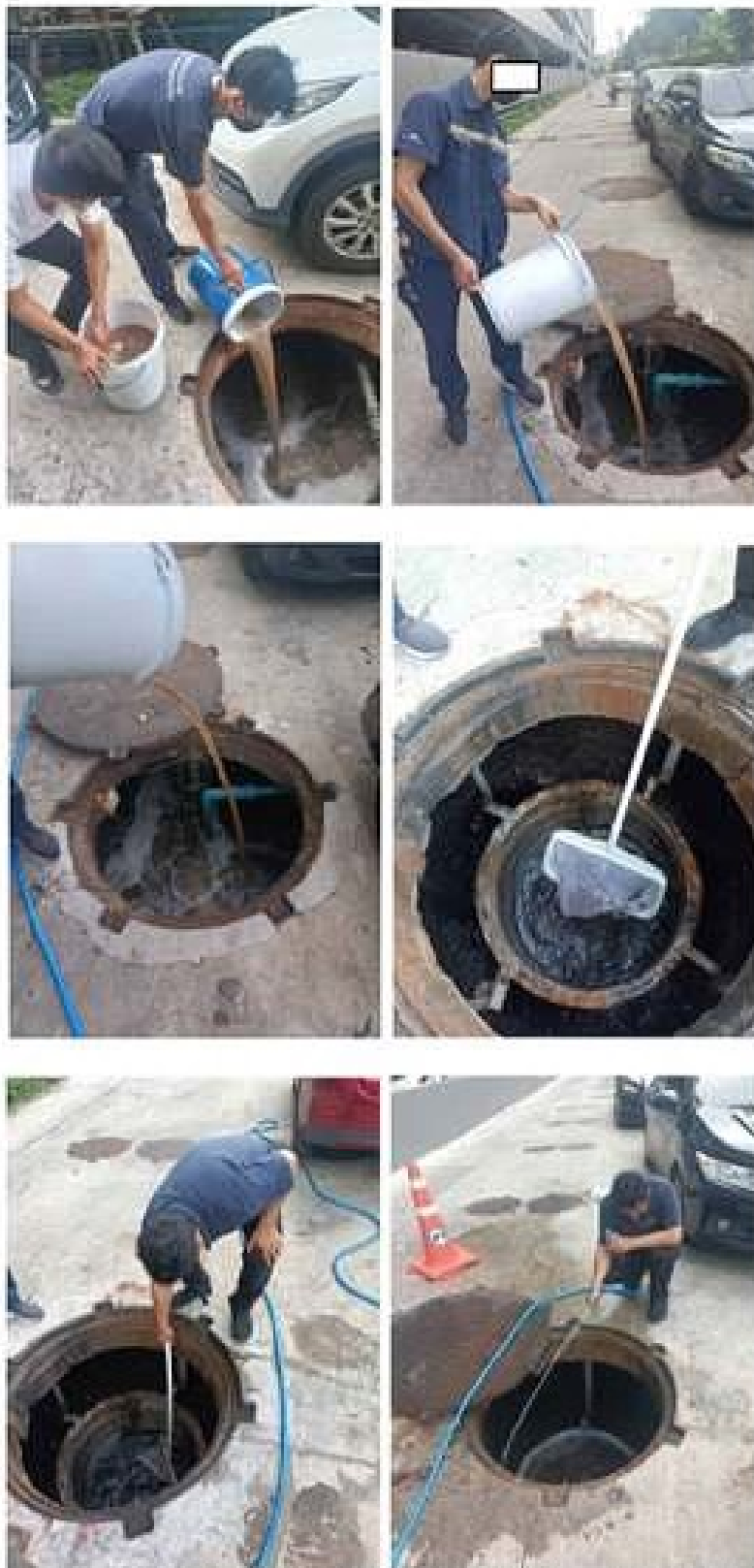
ภาพที่ 3-35 คู่มือการระบายน้ำใต้ดินและเก็บขยะในท่อระบายน้ำใต้ดิน ตรวจสอบและทำความสะอาดคู่มือ
