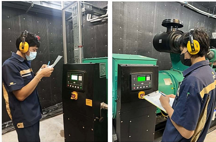
ภาพที่ 3-32 ตรวจสอบระบบไฟฟ้าสำรองฉุกเฉินของโครงการทุกสัปดาห์
