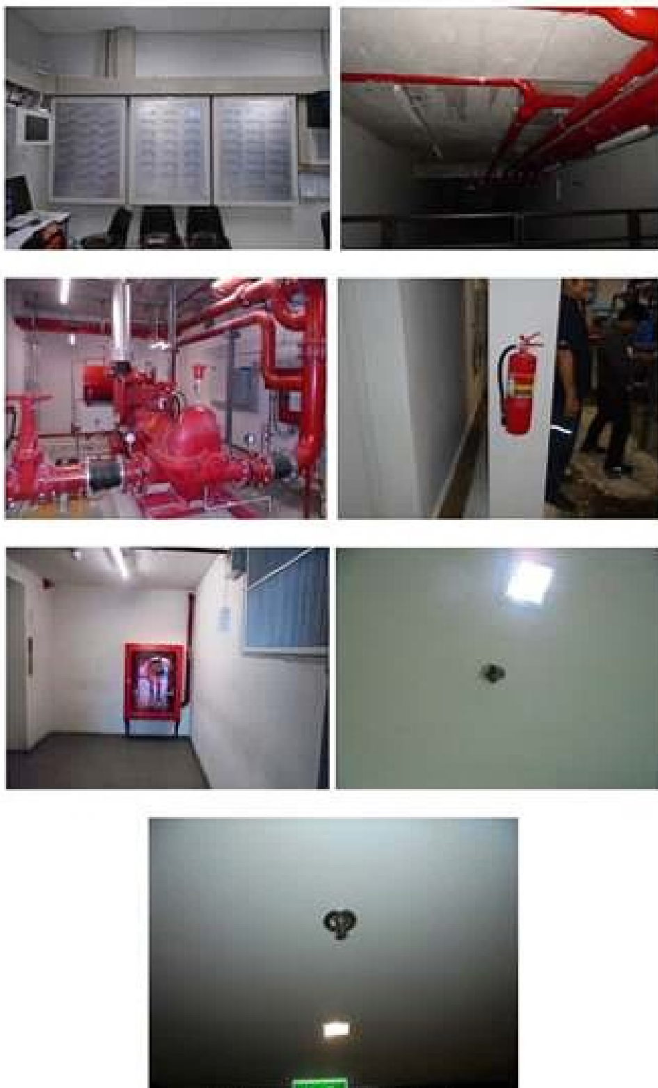
ภาพที่ 3-10 ติดตั้งอุปกรณ์ป้องกันอัคคีภัย
