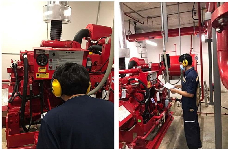
ภาพที่ 3-33 ตรวจสอบระบบดับเพลิง Fire Pump ของโครงการทุกสัปดาห์
