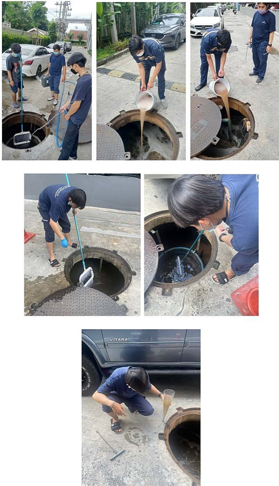
ภาพที่ 3-25 ดูดตะกอนในระบบบำบัดน้ำเสียและบำรุงรักษาระบบบำบัดน้ำเสียของโครงการ
