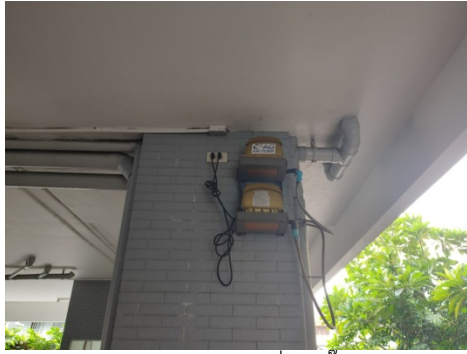
ภาพที่ 4-3 ปัมเติมอากาศในระบบบำบัดน้ำเสียแต่ละส่วน
