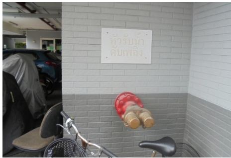
ภาพที่ 4-24 ห้รับน้ำดับเพลิงจากภายนอก
