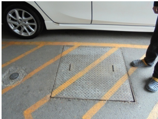
ภาพที่ 4-7 ฝาท่อส่งน้ำใต้ดิน
