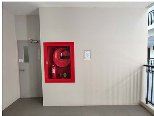
ภาพที่ 3-18 ท่อย่นและตู้เก็บสายชนิดน้ำดับเพลิงและอุปกรณ์
