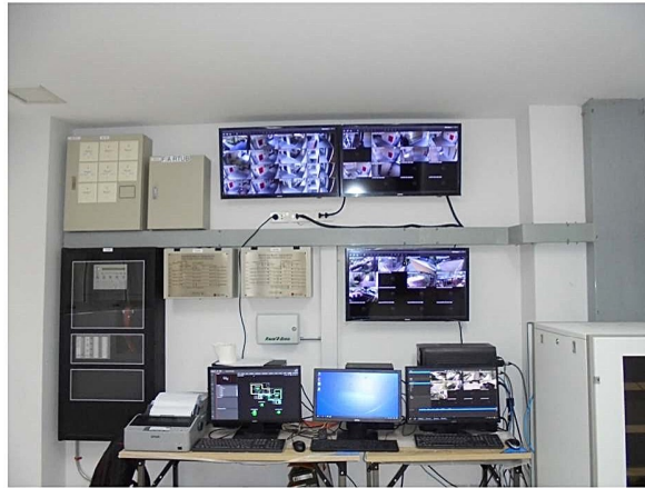
ภาพที่ 3-17 แผงควบคุมอุปกรณ์แจ้งเหตุเพลิงไหม้
