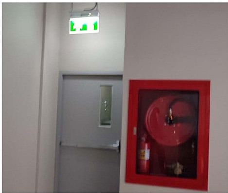
ภาพที่ 3-18 ท่อย่นและตู้เก็บสายชนิดน้ำดับเพลิงและอุปกรณ์
