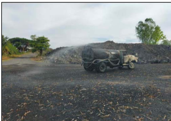
รูปที่ 2-15 การฉีดพรมน้ำบริเวณพื้นที่โครงการและเส้นทางขนส่ง
