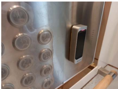
ลิฟต์ระบบคีย์การ์ดและระบบ สแกนหน้า
