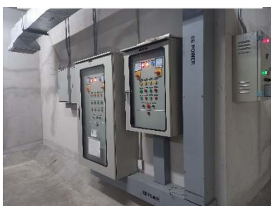
ตู้ควบคุม Transfer Pump
