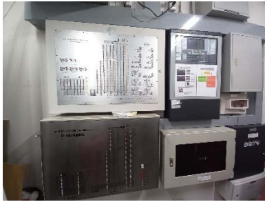
Graphic Annunciator Fire Alarm System และ Fire Fighter Telephone System
