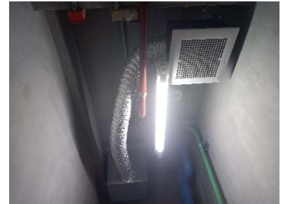
การระบายอากาศในห้องพัสดุฝอย ประจำชั้น
