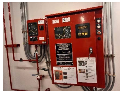
ตู้ควบคุม Fire Pump System
