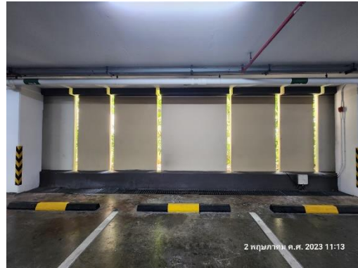
รูปที่ 20 ระบบระบายอากาศภายในอาคารและช่องเปิดระบายอากาศ
