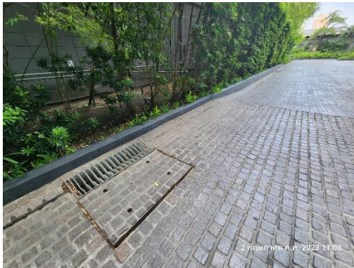
รูปที่ 15 ระบบระบายน้ำและบ่อหน่วงน้ำ
