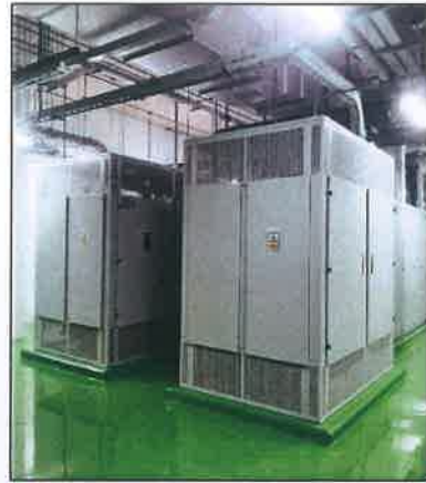
รูปที่ 2-20 หม้อแปลงไฟฟ้าแยกต่างหากจากหม้อแปลงไฟฟ้าของชุมชน
