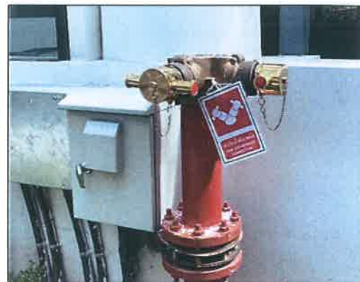
รูปที่ 2-46 หัวรับน้ำดับเพลิงอยู่ภายนอกอาคาร
