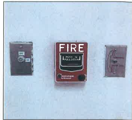
รูปที่ 2-44 ระบบป้องกันอัคคีภัย เช่น สัญญาณเตือนอัคคีภัย อุปกรณ์ ตรวจจับความร้อน และควัน
