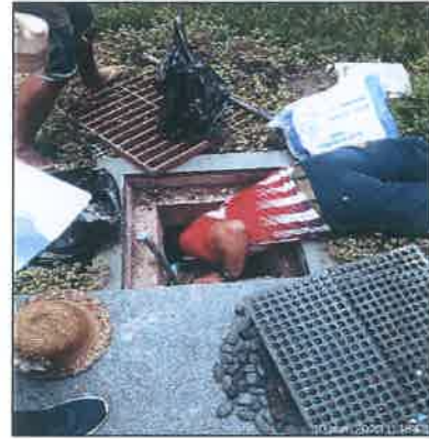
รูปที่ 2-14 ตรวจสอบและดูแลผ้าบ่อ ข้อต่อ และผนังของระบบบำบัดน้ำเสีย
