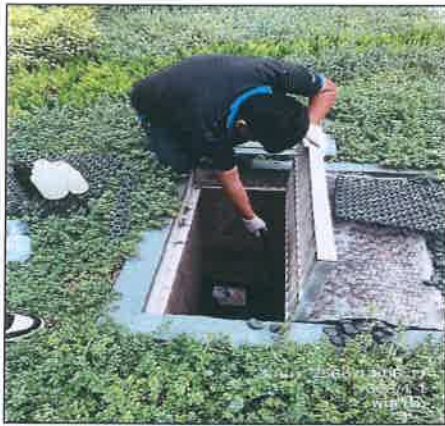
รูปที่ 2-31 บ่อตรวจคุณภาพน้ำพร้อม ตะแกรงดักขยะ
