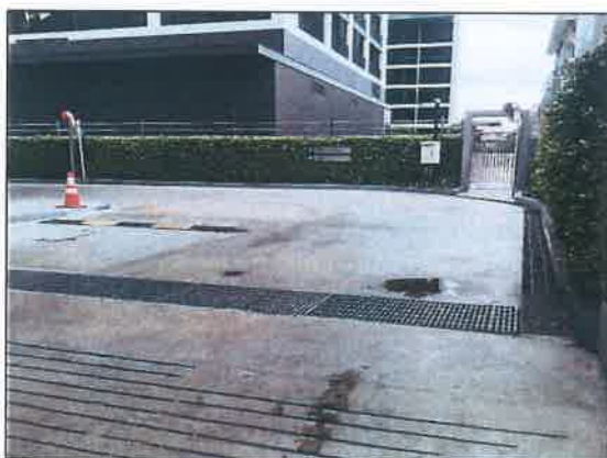
รูปที่ 2-29 ระบบระบายน้ำ ท่อระบายน้ำ คสล. รอบพื้นที่โครงการและบ่อพักน้ำสำเร็จรูปพร้อมบ่อ สูบน้ำฝนรองรับน้ำฝนบริเวณพื้นถนน
