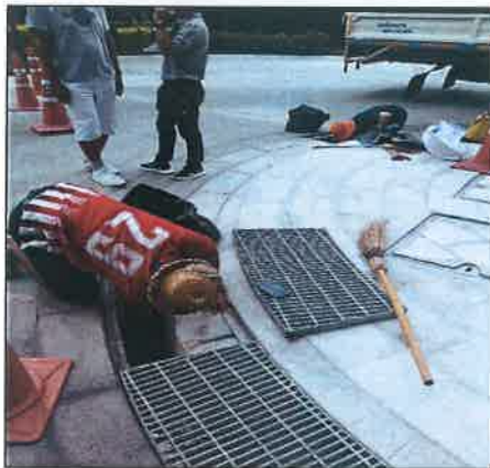
รูปที่ 2-33 การล้างทำความสะอาดท่อระบายน้ำ
