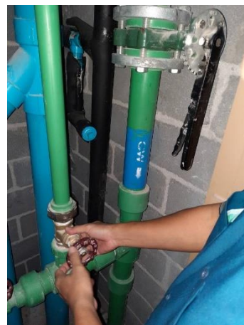
ภาพที่ 2.2-33 การตรวจสอบท่อน้ำใช้ให้อยู่ในสภาพดี และไม่พบการชำรุด หรือรั่วไหลของน้ำ
