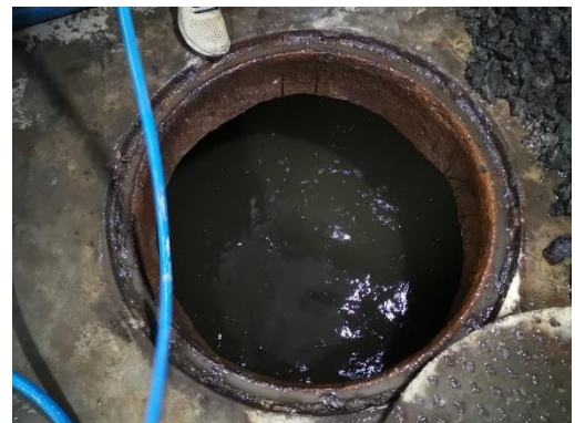
ภาพที่ 2.2-8 สูบตะกอนในถังเก็บตะกอนจากระบบบำบัดน้ำเสีย
