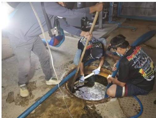
ภาพที่ 2.2-8 สูบตะกอนในถังเก็บตะกอนจากระบบบำบัดน้ำเสีย
