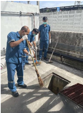
ภาพที่ 2.2-12 เก็บกวาดเศษขยะบริเวณตะแกรงดักขยะก่อนเข้าสู่บ่อท่อน้ำฝนและก่อนระบายออกสู่ภายนอกโครงการ
