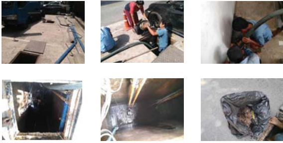
การสูบล้างท่อจากระบบบำบัดน้ำเสีย
