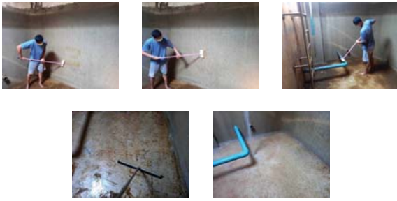
การล้างถังเก็บน้ำภายในโครงการ
