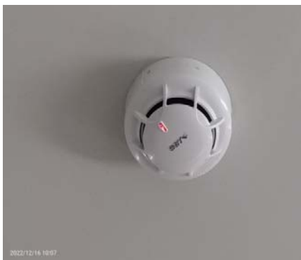
รูปที่ 2.1-56 เครื่องตรวจจับควัน
