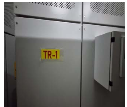
รูปที่ 2.1-55 หม้อแปลงไฟฟ้า ชนิด Dry Type
