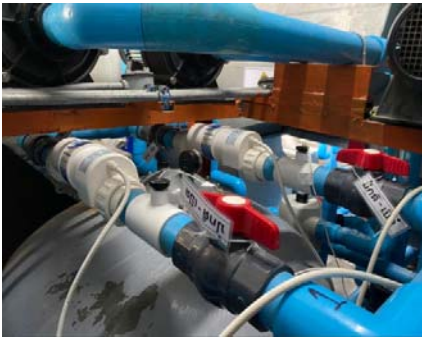
รูปที่ 2.1- 23 ระบบเกลือฆ่าเชื้อโรคสระว่ายน้ำ
