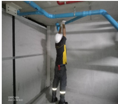
รูปที่ 2.1-51 ท่อรวบรวมน้ำเสียห้องขยะ
