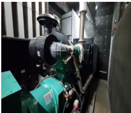
รูปที่ 2.1-53 เครื่องกำเนิดไฟฟ้าสำรอง
