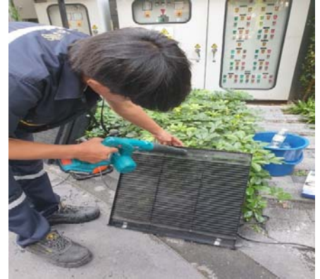
รูปที่ 2.1-61 การล้างทำความสะอาดแผ่นกรองอากาศ
