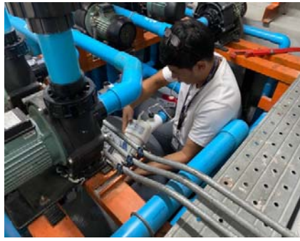
รูปที่ 2.1-24 การเดินระบบกรองน้ำของสระว่ายน้ำ
