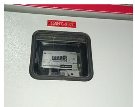
รูปที่ 2.1-14 มิเตอร์ไฟฟ้าระบบบำบัดน้ำเสีย
