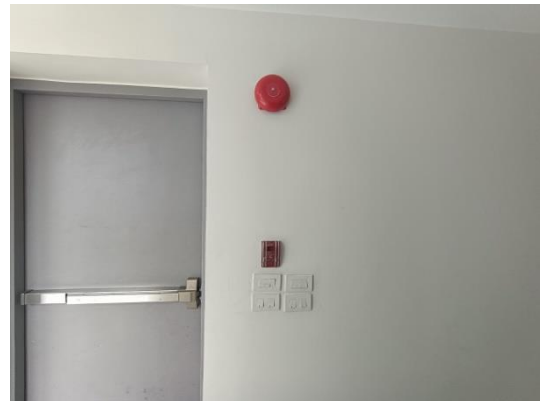
รูปที่ 2-3 สัญญาณเตือนอัคคีภัยแบบมือดึง
