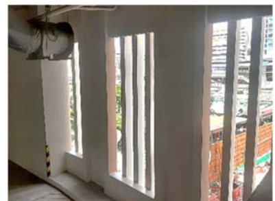
ช่องระบายอากาศภายในอาคารจอดรถ
