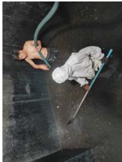
การสูบลบตะกอนและไขมันระบบบำบัดน้ำเสีย
