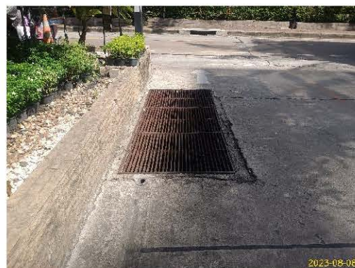
ท่อระบายน้ำก่อนออกโครงการ พร้อมตะแกรงดักขยะ
