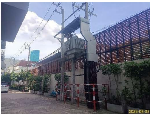
หม้อแปลงไฟฟ้าขนาด 1250 KVA อาคาร A
