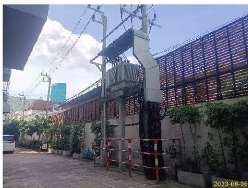
หม้อแปลงไฟฟ้าขนาด 1250 KVA อาคาร A
