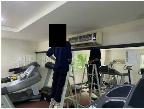
การทำความสะอาดเครื่องปรับอากาศพื้นที่ส่วนกลาง
