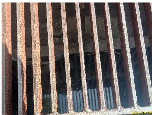
ท่อระบายน้ำก่อนออกโครงการ พร้อมตะแกรงดักขยะ
