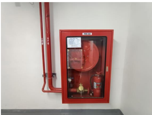
รูปที่ 2-38 ตู้เก็บอุปกรณ์ดับเพลิง
