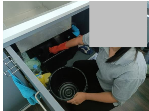
รูปที่ 2-31 ทำความสะอาดถังดับไขมันเป็นประจำ
