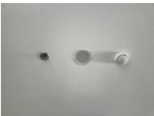
รูปที่ 2-3 สปริงเกอร์น้ำดับเพลิง เครื่องตรวจจับควัน
