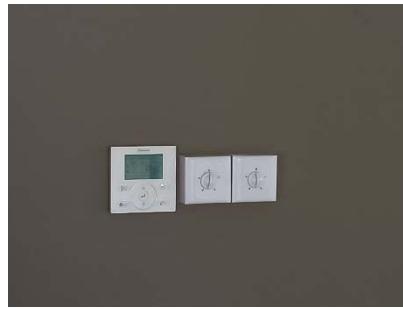
ตัวปรับอุณหภูมิเครื่องปรับอากาศ
