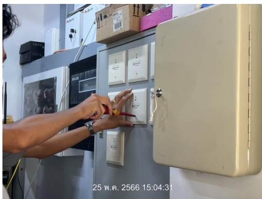
รูปที่ 2-45 ตรวจสอบแผงควบคุม Fire Alarm
