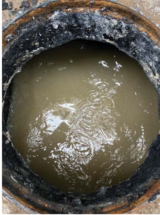
- หลังจากสูบล้างไขมันในบ่อดักไขมันท่อแล้ว
