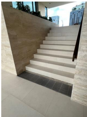
รูปที่ 2-50 ตะแกรงครอบคลุมรูปท่อระบายน้ำทั้งภายในและภายนอกอาคาร
