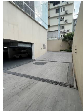
รูปที่ 2-50 ตะแกรงครอบคลุมรูปท่อระบายน้ำทั้งภายในและภายนอกอาคาร
