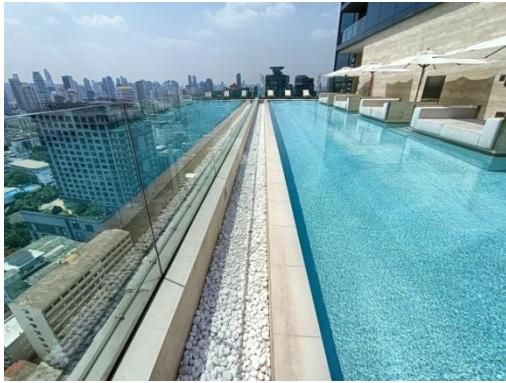
รูปที่ 2-24 รางระบายน้ำล้นมีฝาปิดรอบสระว่ายน้ำ น้ำความกว้าง 30-40 เซนติเมตร
