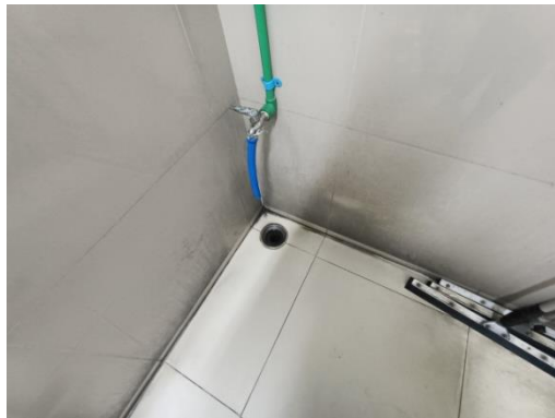
รูปที่ 2-33 ท่อรวบรวมน้ำเสียที่เกิดจากการล้างห้องพักมูลฝอยรวมเข้าสู่ระบบบำบัดน้ำเสีย
