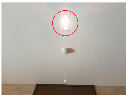
รูปที่ 2-39 ใช้หลอดไฟประหยัดพลังงาน Light Emitting Diode (LED)
