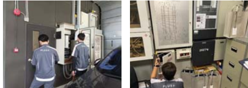
การตรวจสอบระบบป้องกันและเตือนอัคคีภัยในโครงการ
