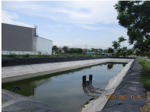
ภาพที่ 2-3 บ่อพักน้ำทั้งหมดขนาด 15,000 ลบ.ม.
