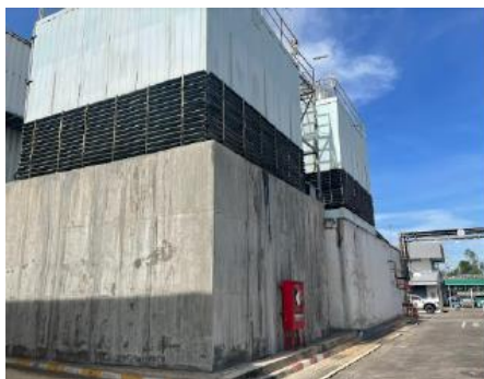
ภาพที่ 2-31 ถังเก็บน้ำดับเพลิงสำรองของโรงงาน
