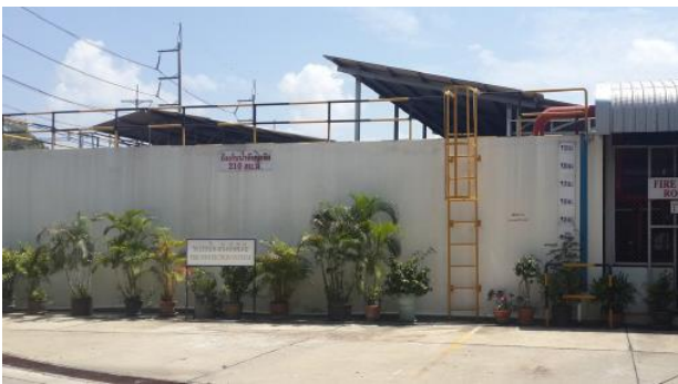
ภาพที่ 2-31 (ต่อ) ถังเก็บน้ำดับเพลิงสำรองของโรงงาน
