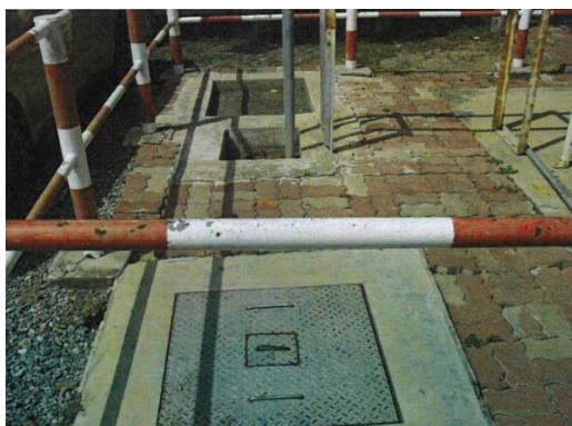
ภาพที่ 2-13 ตัวอย่างบ่อพักน้ำทิ้งหลังการบำบัดของโรงงาน
