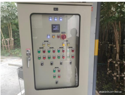
รูปที่ 29 ตู้ควบคุมระบบบำบัดน้ำเสียและมิเตอร์น้ำเสีย
