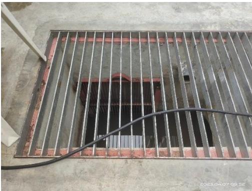
รูปที่ 27 ตะแกรงดักขยะบ่อบำบัดก่อนออกจาก โครงการ
