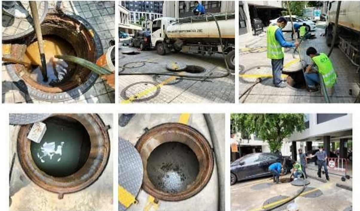
ภาพที่ 3-31 ซ่อมบำรุงระบบน้ำบาดาลเสีย สืบตะกอนในบ่อบาดาลและทำความสะอาด และระหว่างดำเนินการรักษาบกพร่อง และดำเนินการในช่วงกลางกลางวัน
