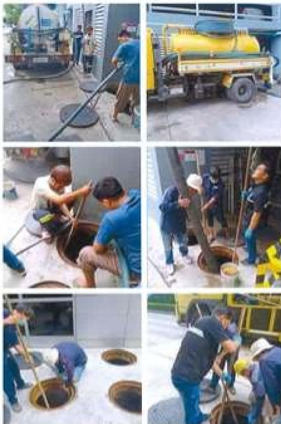
ภาพที่ 3-25 การตรวจสอบท่อระบายน้ำ
