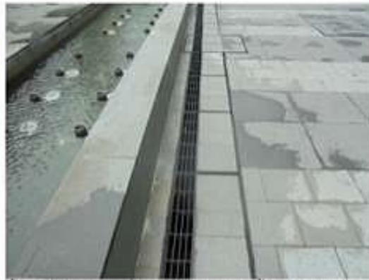
ภาพที่ 3-39 ระบบ Stop log ใช้ระดับน้ำภายในโครงการเมื่อถึงระดับที่ระบายน้ำออกจะไหลล้นออก และน้ำภายนอกไม่สามารถไหลเข้า
