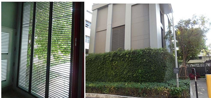
ภาพที่ 3-13 ช่องเปิดระบายอากาศที่ห้องเครื่องไฟฟ้า
