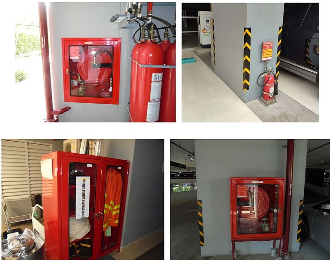
ภาพที่ 3-23 ท่อขึ้น และตู้เก็บสายฉีดน้ำดับเพลิงและอุปกรณ์
