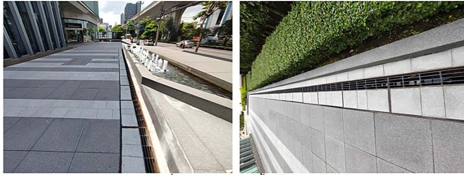
ภาพที่ 3-10 ระบบระบายน้ำของโครงการ
