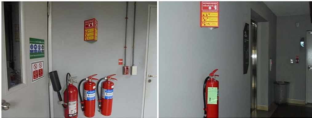
ภาพที่ 3-14 ถังเคมีดับเพลิง
