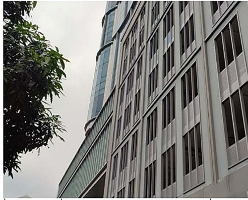
ภาพที่ 3-2 กระจกที่ใช้เป็นกระจกมีค่าการสะท้อนแสงต่ำกว่าร้อยละ 30
