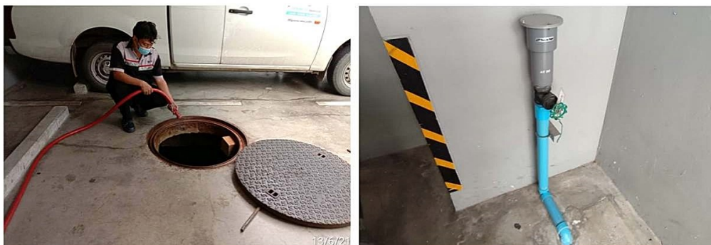
ภาพที่ 3-6 ระบบบำบัดน้ำเสียรวมอยู่ใต้พื้นที่จอดรถชั้นล่างของอาคารและมอเตอร์ไฟฟ้าแยกเฉพาะระบบบำบัดน้ำเสีย
