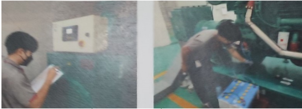
ภาพที่ 3-47 ช่างอาคารทดสอบเครื่องย่นตีกำเนตไฟฟ้าสำรอง
