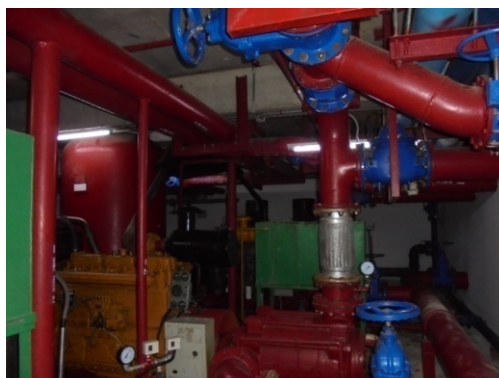
ภาพที่ 3-17 ห้องปั๊มน้ำและปั๊มสูบน้ำดับเพลิง
