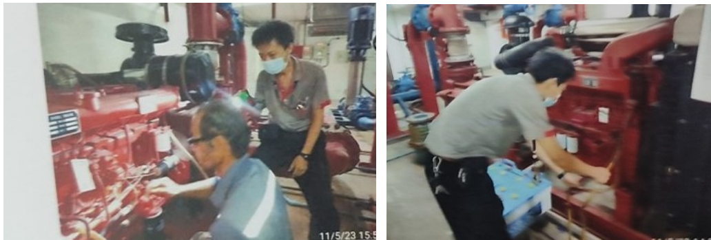
ภาพที่ 3-48 ช่างอาคารทดสอบเครื่องสูบน้ำดับเพลิง
