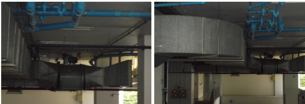
ภาพที่ 3-6 ช่องเปิดระบายอากาศที่ชั้นจอดรถ และพัดลมกรองอากาศติดตั้งไว้ที่ชั้น 4 ของอาคารจอดรถ
