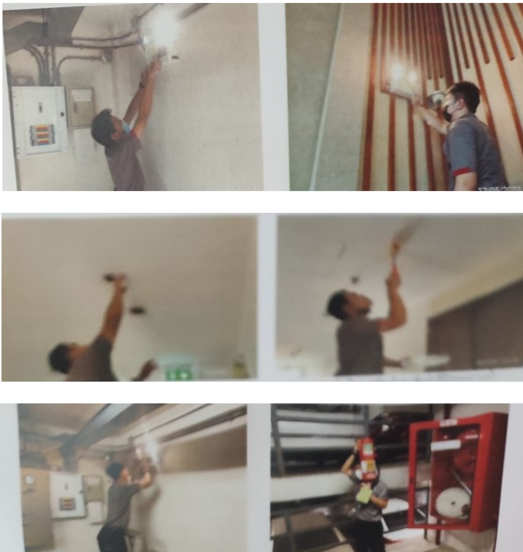
ภาพที่ 3-52 ช่างอาคารตรวจสอบระบบป้องกันและเตือนอัคคีภัย
