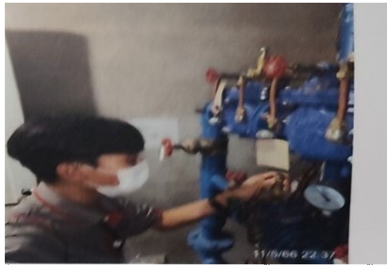
ภาพที่ 3-51 ช่างอาคารตรวจสอบวาล์วลดแรงดันน้ำ ระบบการจ่ายน้ำประปา
