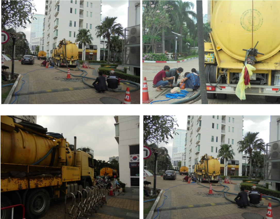
ภาพที่ 3-38 การสูบล้างปฏิกรณ์ในบ่อเกรอะ
