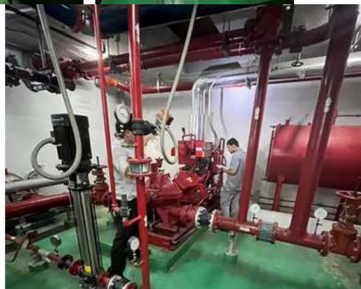
ภาพที่ 4-32 ตรวจสอบระบบไฟฟ้าและไฟฟ้าสำรอง และเครื่องสูบน้ำดับเพลิง
