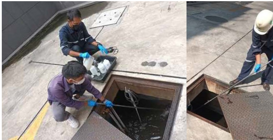
ภาพที่ 4-8 สูดตะกอนออกจากบ่อเกรอะและถังเก็บตะกอน ดูและระบบบำบัดน้ำเสีย
