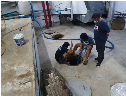
สูบล้างปลวกออกจากบ่อดักไขมัน และเติมสารชีวภาพในบ่อดักไขมัน ภาพที่ 3-27 ดูตะกอนไขมันและตะกอนในบ่อกักเก็บตะกอนของระบบบำบัดน้ำเสีย
