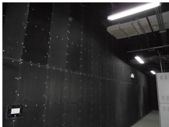
ภาพที่ 3-26 ห้องเครื่องไฟฟ้าฉุกเฉินมีระบบฉนวนป้องกันเสียงดัง ปล่องไอเสีย และเครื่องตรวจจับความร้อน
