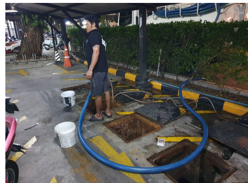
สูบล้างปลวกออกจากบ่อดักไขมัน และเติมสารชีวภาพในบ่อดักไขมัน ภาพที่ 3-27 ดูตะกอนไขมันและตะกอนในบ่อกักเก็บตะกอนของระบบบำบัดน้ำเสีย
