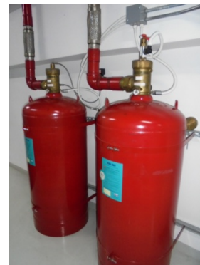
ถังดับเพลิงเคมีและระบบหัวกระจายน้ำดับเพลิงภายในห้องไฟฟ้า MDB
