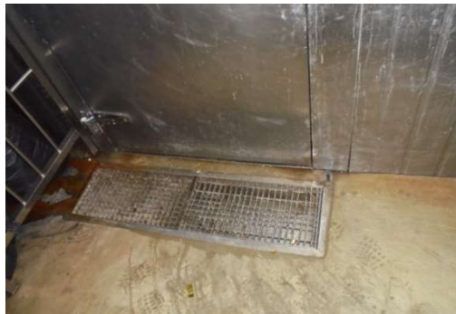
ภาพที่ 3-13 รางระบายน้ำภายในห้องพัสดุโดยรวม
