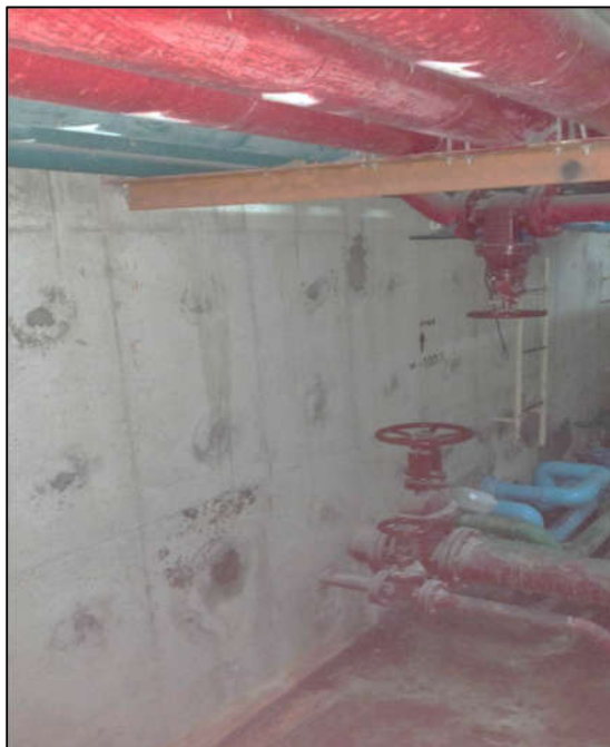
ภาพที่ 48 แสดงระบบจ่ายน้ำและระบบเส้นท่อประปา
