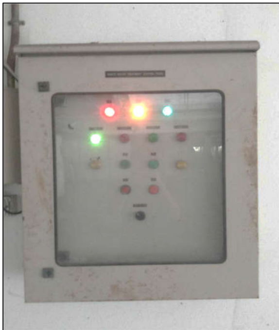
ภาพที่ 49 แสดงตู้คอนโทรลควบคุมการทำงานของเครื่องเติมอากาศ
