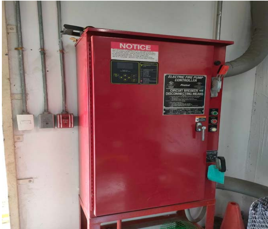
ภาพที่ 9 แสดงตู้ควบคุมระบบดับเพลิง ภายใน โครงการ
