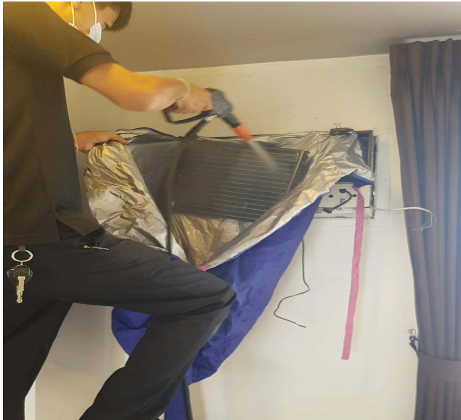
ภาพที่ 31 เจ้าหน้าที่ทำการล้างเครื่องปรับอากาศภายในโครงการ
