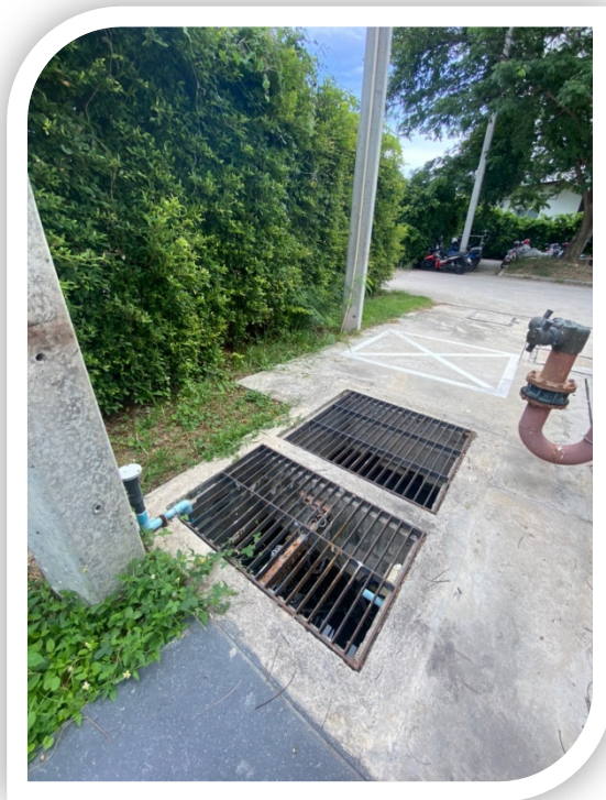
ภาพที่ 15 แสดงบ่อหน้าวงน้ำฝนของโครงการ
