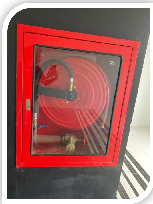
ภาพที่ 29 แสดงตู้เก็บสายน้ำดับเพลิง-ถังดับเพลิงแสดงถังดับเพลิง
