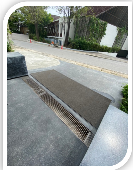
ภาพที่ 16 และ 17 แสดงตะแกรงดักมูลฝอย
