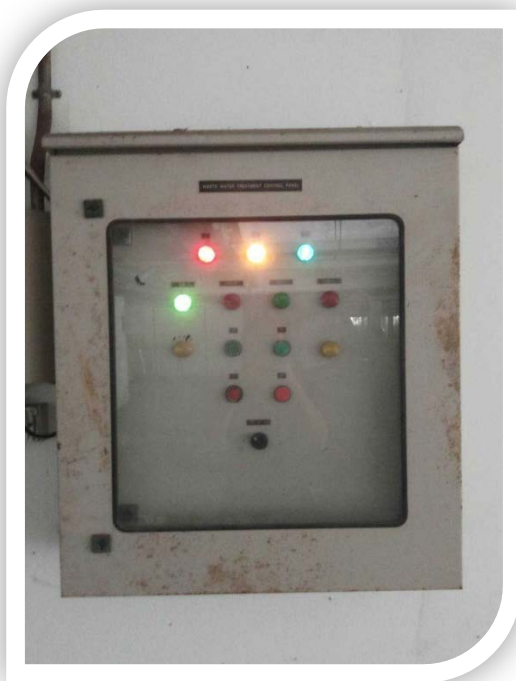
ภาพที่ 11 แสดงตู้คอนโทรลควบคุมการทำงานของเครื่องเติมอากาศ
