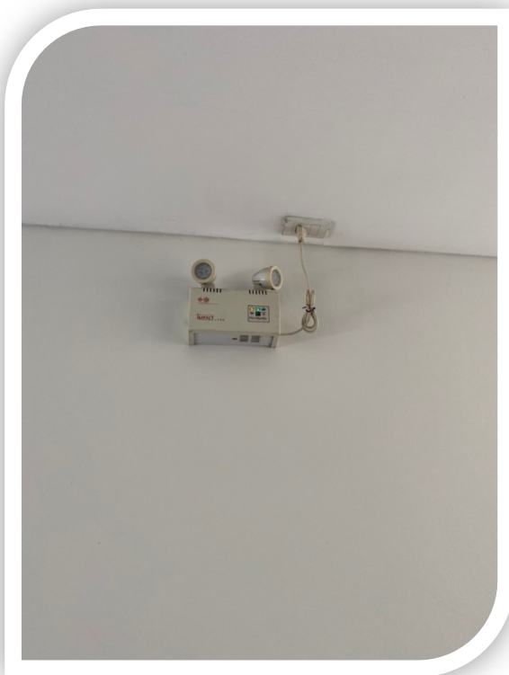
ภาพที่ 28 แสดงไฟส่องสว่างฉุกเฉิน
