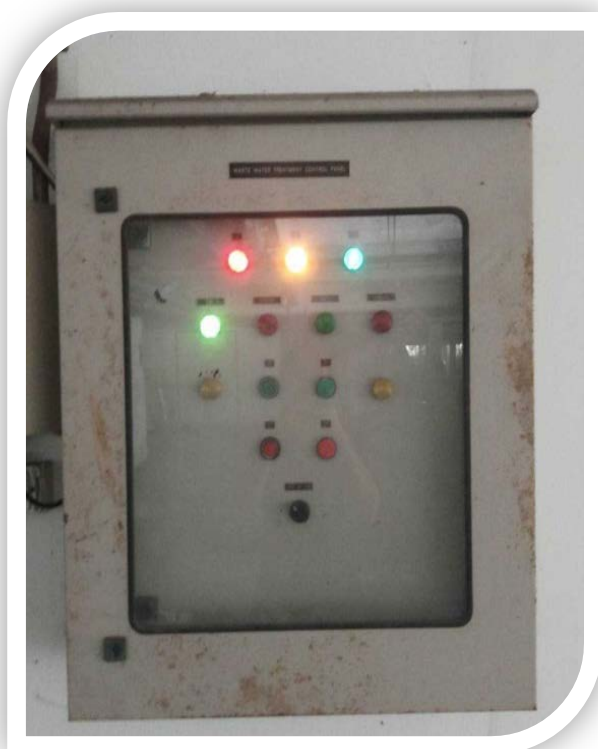
ภาพที่ 31 แสดงตู้คอนโทรลควบคุมการทำงานของระบบน้ำเสีย
