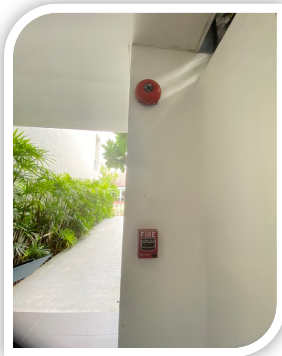
ภาพที่ 17 ระบบสัญญาณแจ้งเหตุเพลิงไหม้
