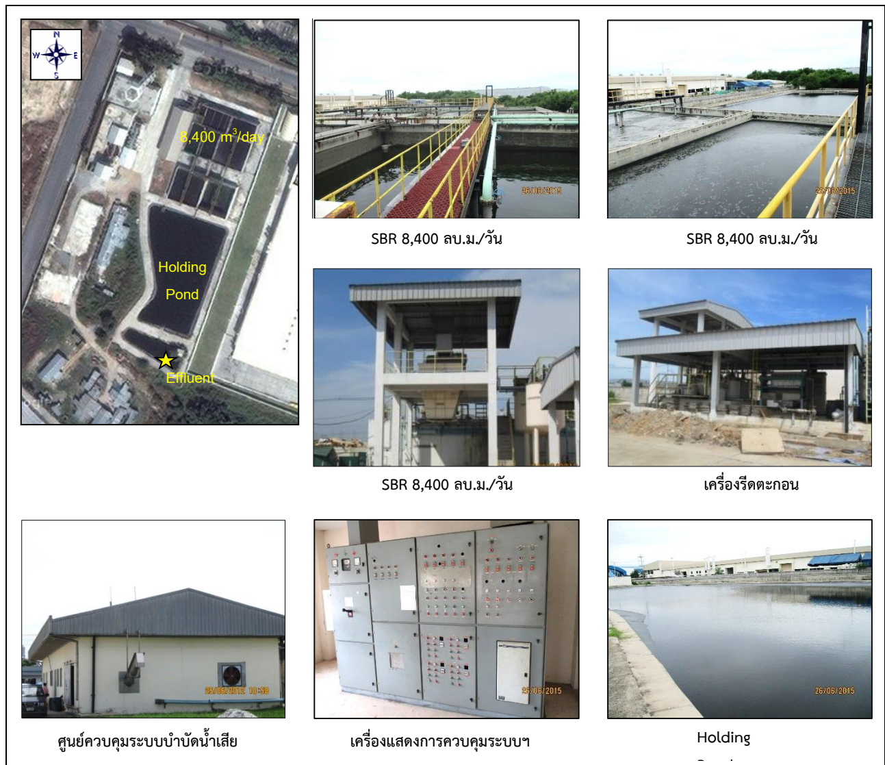
ภาพที่ 1-3 ระบบบำบัดน้ำเสียทางชีวภาพสำหรับพื้นที่โครงการ ระยะที่ 3 และ 4
