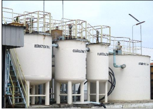
ภาพที่ 1-4 ระบบบำบัดน้ำเสียส่วนกลางทางเคมี
