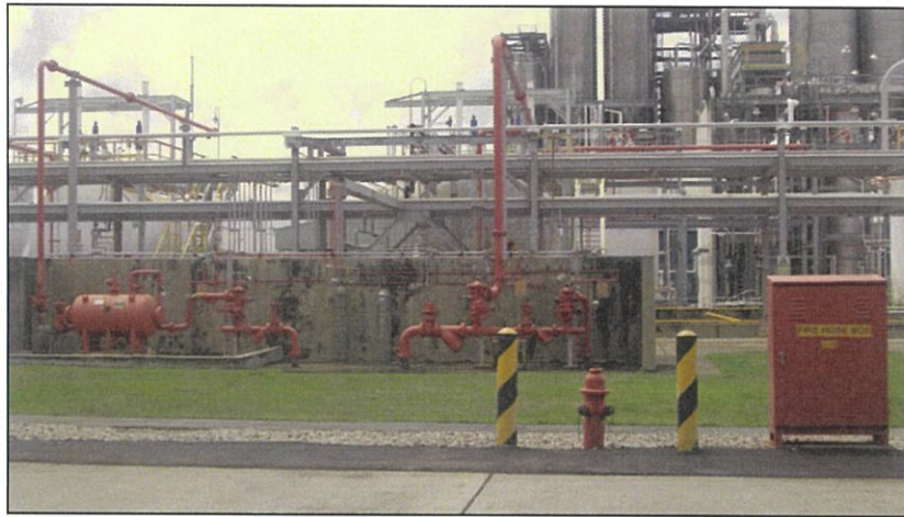
ระบบโหมดับเพลิง และสายดับเพลิง บริเวณถังเก็บวัตถุดิบ
