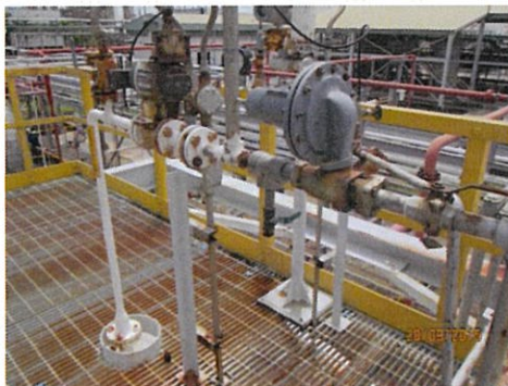
วาล์วควบคุมความดัน Pressure Control Valve
