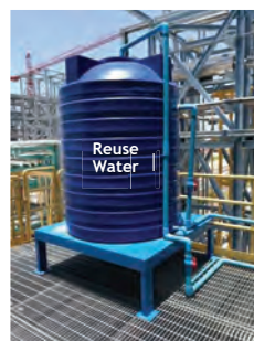
Tank เก็บน้ำ Blow down และการเดินท่อเพื่อนำน้ำกลับมาใช้ใหม่ในกระบวนการ
