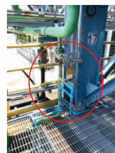
Tank เก็บน้ำ Blow down และการเดินท่อเพื่อนำน้ำกลับมาใช้ใหม่ในกระบวนการ
