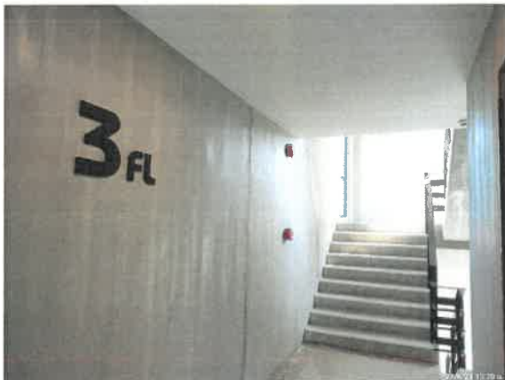
รูปที่ 2-36 แสดงกริ่งสัญญาณเตือนภัย และเครื่องแจ้งเหตุโดยใช้อัตโนมัติ บริเวณด้านหน้าลิฟต์แต่ละชั้นของโครงการ
