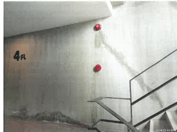
รูปที่ 2-36 แสดงกริ่งสัญญาณเตือนภัย และเครื่องแจ้งเหตุโดยใช้อัตโนมัติ บริเวณด้านหน้าลิฟต์แต่ละชั้นของโครงการ
