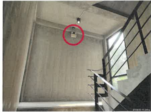
รูปที่ 2-35 แสดงระบบไฟส่องสว่างฉุกเฉิน (Emergency light) บริเวณบันไดหลัก และบริเวณทางเดินแต่ละชั้นของโครงการ
