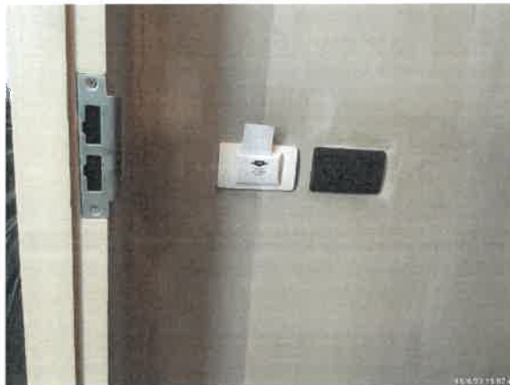
รูปที่ 2-45 แสดงระบบคีย์การ์ดควบคุมระบบไฟฟ้าภายในห้องพักทั้งหมด
