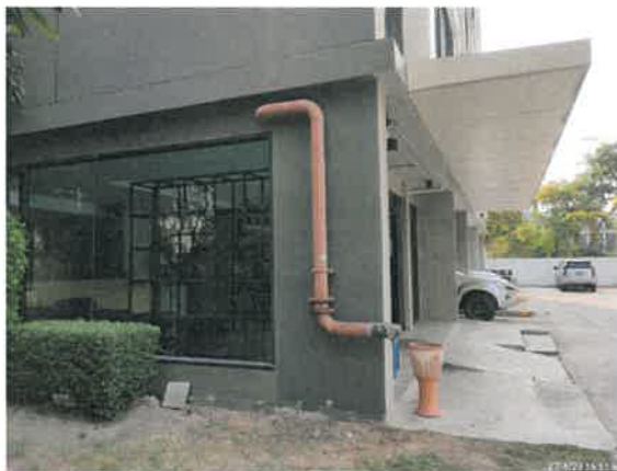
รูปที่ 2-37 แสดงติดตั้งหัวรับน้ำดับเพลิง FDC บริเวณด้านหน้าโครงการ
