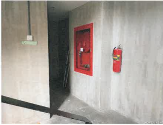
รูปที่ 2-33 แสดงตู้เก็บสายฉีดน้ำดับเพลิง (Fire Hose Cabinet) และถังดับเพลิงแบบมือถือ บริเวณข้างลิฟต์แต่ละชั้นของโครงการ (ต่อ)
