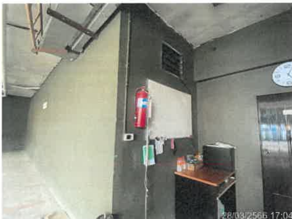
รูปที่ 2-33 แสดงตู้เก็บสายฉีดน้ำดับเพลิง (Fire Hose Cabinet) และถังดับเพลิงแบบมือถือ บริเวณข้างลิฟต์แต่ละชั้นของโครงการ
