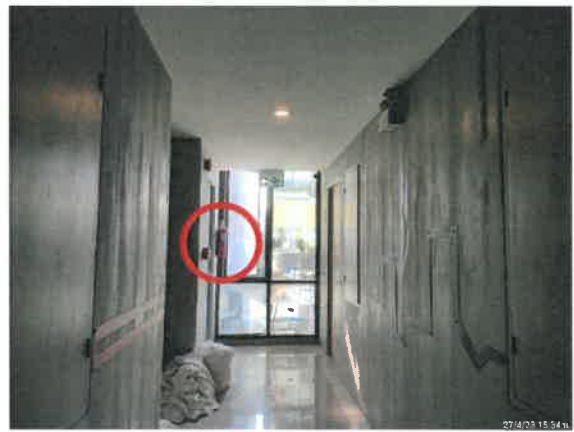
รูปที่ 2-33 แสดงตู้เก็บสายฉีดน้ำดับเพลิง (Fire Hose Cabinet) และถังดับเพลิงแบบมือถือ บริเวณข้างลิฟต์แต่ละชั้นของโครงการ (ต่อ)
