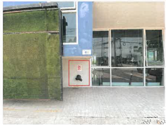
รูปที่ 2-38 แสดงติดตั้งหัวรับน้ำดับเพลิง FDC บริเวณที่จอดรถด้านข้างอาคารโครงการ
