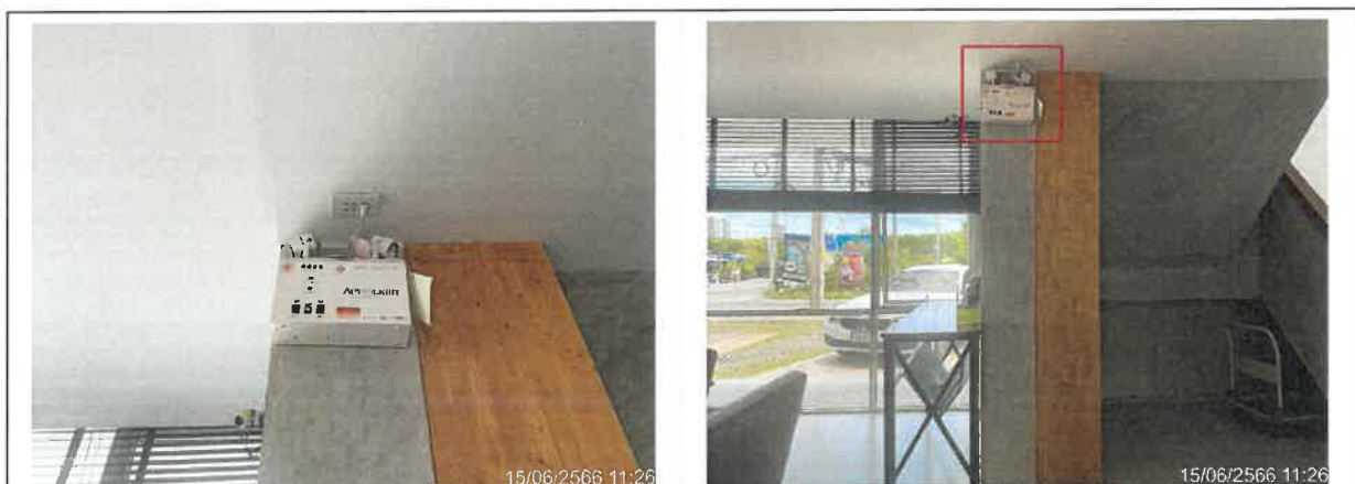
รูปที่ 2-36 แสดงระบบไฟส่องสว่างฉุกเฉิน (Emergency light)
