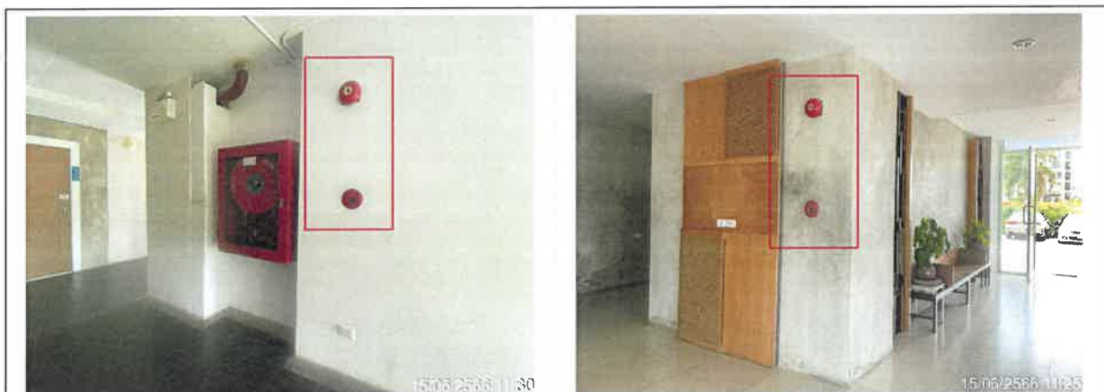
รูปที่ 2-37 แสดงกริ่งสัญญาณเตือนภัย (Alarm Bell) และเครื่องแจ้งเหตุโดยใช้มือถือ (Fire Manual Station Unit)
