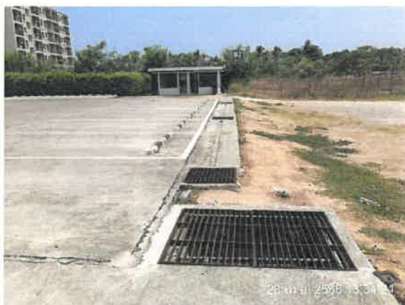
รูปที่ 2-18 แสดงบ่อพักน้ำ และตะแกรงดักมูลฝอยบริเวณจุดระบายน้ำออกจากท่อระบายน้ำของโครงการ
