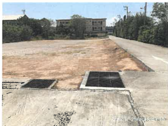
รูปที่ 2-18 แสดงบ่อพักน้ำ และตะแกรงดักมูลฝอยบริเวณจุดระบายน้ำออกจากท่อระบายน้ำของโครงการ
