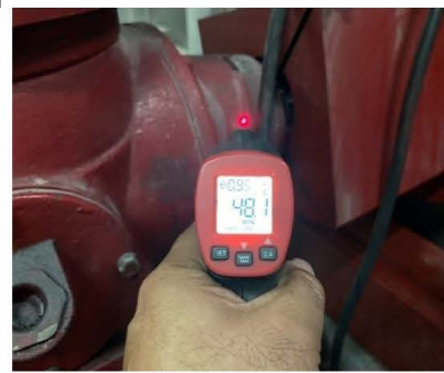
ภาพขณะตรวจวัดอุณหภูมิปั้มขณะทำงาน
