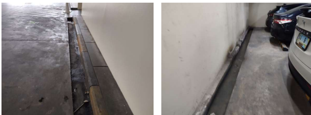
ภาพที่ 4-23 ลอกท่อระบายน้ำ มีตะแกรงดักขยะ ปัจจุบันสามารถระบายน้ำได้เป็นอย่างดี
