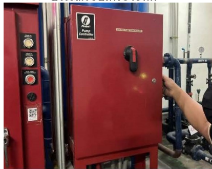
ภาพขณะตรวจเช็คตู้ JOCKEY PUMP CONTROLLER
