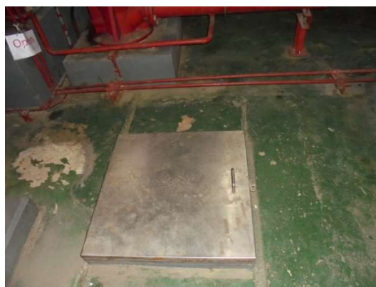
ภาพที่ 4-24 สภาพฝาลังสำรอน้ำใต้ดิน ปิดมิดชิดและมีขอบยกสูงจากพื้น
