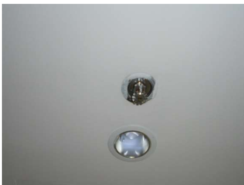
ภาพที่ 4-11 ระบบสัญญาณแจ้งเหตุเพลิงไหม้ และหัวกระจายน้ำดับเพลิงอัตโนมัติ หลอดประหยัดไฟ LED
