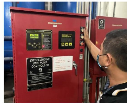
ภาพขณะตรวจเช็คตู้ FIRE PUMP CONTROLLER
