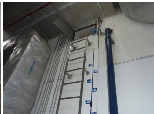
ภาพที่ 4-20 ถังสำรองน้ำใต้ดินและถังสำรองน้ำชั้นดาดฟ้า
