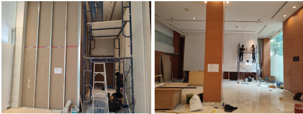
ภาพที่ 4-35 ก่อสร้างปรับปรุงส่วนต้อนรับชั้นล่างโดยกันเป็นสัดส่วนเพื่อความปลอดภัย
