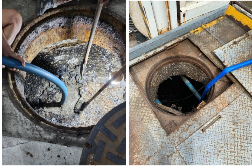
ภาพที่ 4-26 ดูตะกอนจากบ่อเกรอะ
