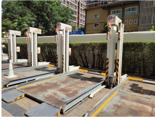
ภาพที่ 4-7 ที่จอดรถแบบ 2 Layer Lifting-Sliding Type ติดตั้งไว้ที่ทิศตะวันตกและทิศตะวันออกของโครงการอยู่ระหว่างซ่อมแซม
