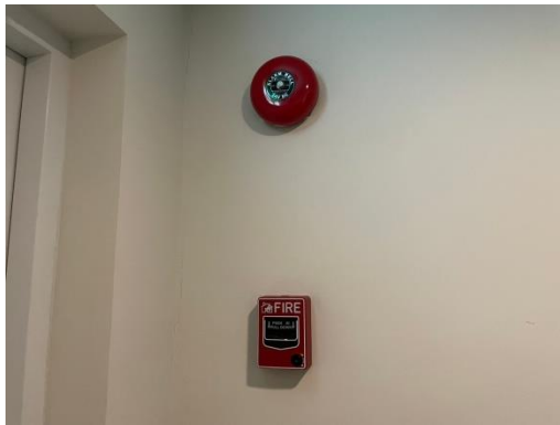
รูปที่ 2-30 สัญญาณแจ้งเตือนแบบกริ่ง และอุปกรณ์แจ้งเตือนเหตุแบบมือดึง
