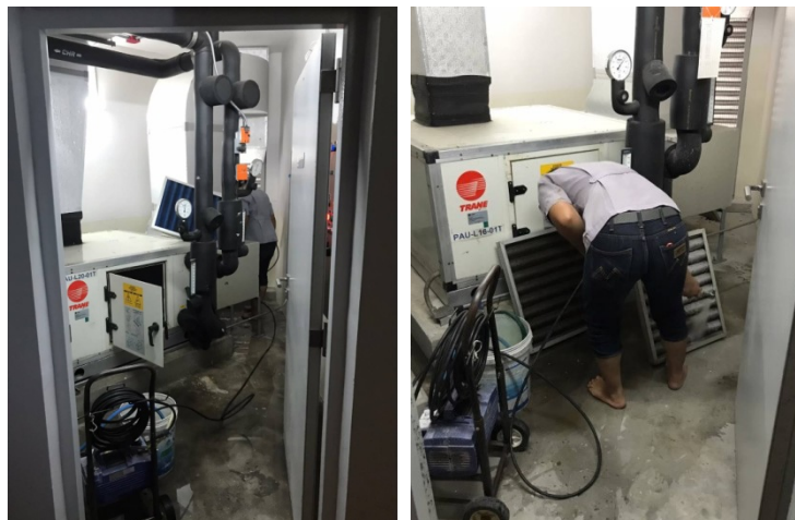
ภาพที่ 4-64 ล้างทำความสะอาดระบบปรับอากาศ และCooling Tower
