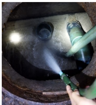
ภาพที่ 4-51 ดูตะกอนไขมันและถังเก็บตะกอนในระบบบำบัดน้ำเสีย
