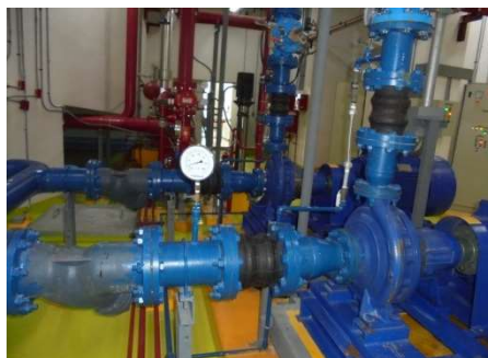
ภาพที่ 4-14 ห้องเครื่องสูบน้ำประปาและเครื่องสูบน้ำดับเพลิง
