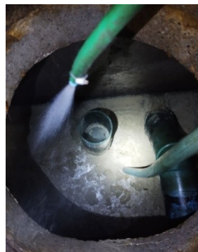
ภาพที่ 4-51 ดูตะกอนไขมันและถังเก็บตะกอนในระบบบำบัดน้ำเสีย
