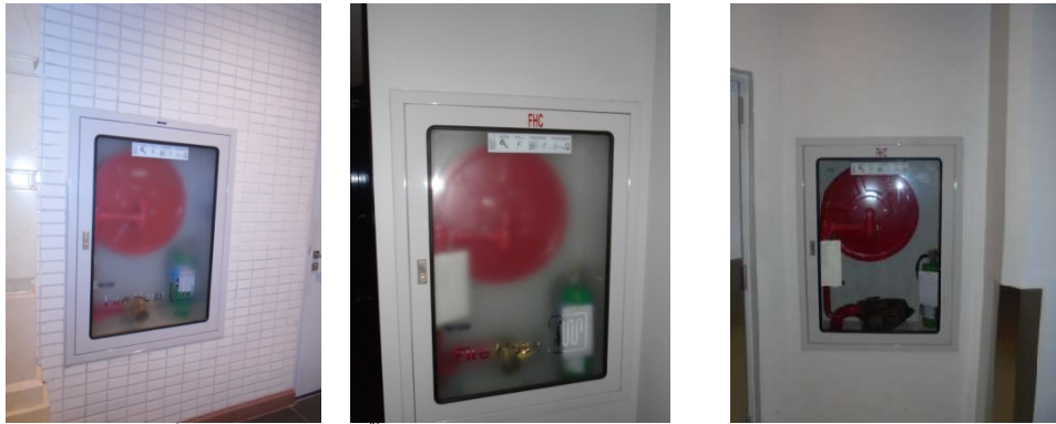
ภาพที่ 4-31 ตู้เก็บสายฉีดน้ำดับเพลิงพร้อมอุปกรณ์ส่วนสรรพสินค้าพาณิชย์ และส่วนโรงแรม
