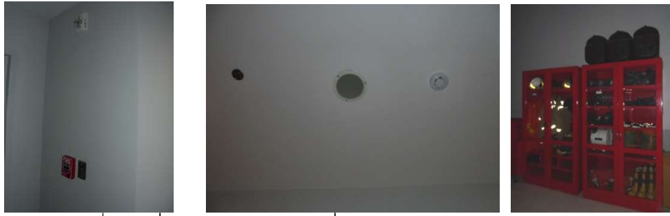
ภาพที่ 4-35 เครื่องแจ้งเหตุโดยใช้มือดึงและกริ่งสัญญาณเตือนภัย และตู้เก็บชุดผจญเพลิง
