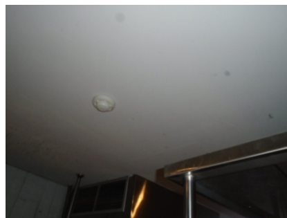
ภาพที่ 4-34 เครื่องตรวจจับความร้อนในห้องครัว
