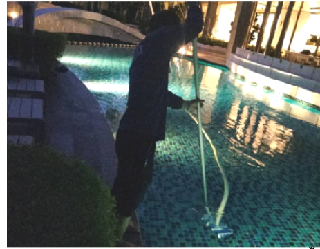
ภาพที่ 4-16 สระว่ายน้ำชั้น 6 เป็นระบบเกลือ (Salt Chlorination) และทำความสะอาดล้าง ดูดตะกอนสระว่ายน้ำ
