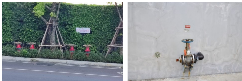
ภาพที่ 4-30 หัวรับน้ำดับเพลิงจากภายนอกส่วนโรงแรม และส่วนสรรพสินค้าพาณิชย์
