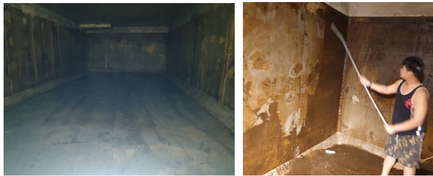
ภาพที่ 4-53 ล้างถังสำรองน้ำใช้
