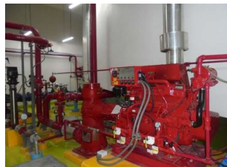
ภาพที่ 4-14 ห้องเครื่องสูบน้ำประปาและเครื่องสูบน้ำดับเพลิง
