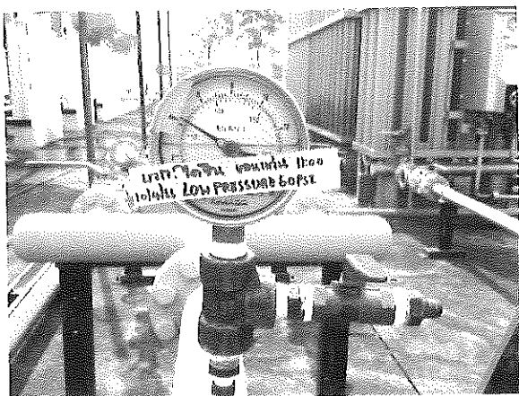
รูปที่ 9, 10 ภาพแสดงการทดสอบแรงดันของระบบท่อ
