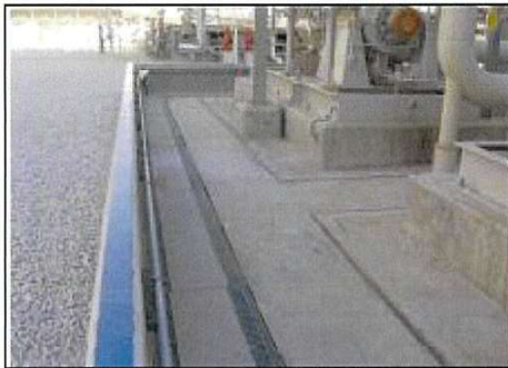
ภาพที่ 2.2-28 คันคอนกรีตล้อมรอบบริเวณที่มีการเก็บกักสารเคมี
