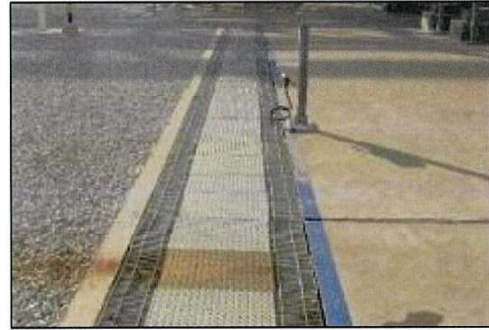
รางระบายน้ำที่มีโอกาสปนเปื้อน
