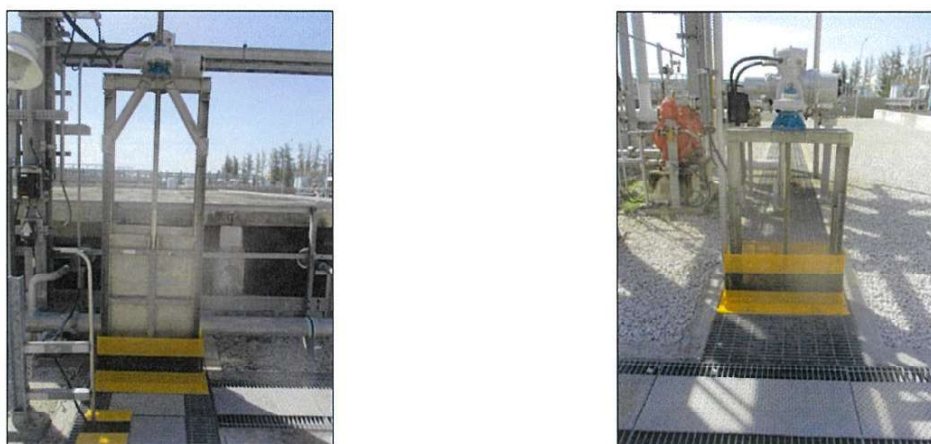
ภาพที่ 2.2-36 การติดตั้งประตูกั้นน้ำบริเวณรางระบายน้ำฝนปนเปื้อนก่อนเข้าบ่อพักน้ำฝนปนเปื้อน
