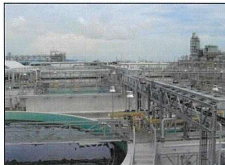
ภาพที่ 2.2-8 ระบบบำบัดน้ำเสียแบบเอเอส
