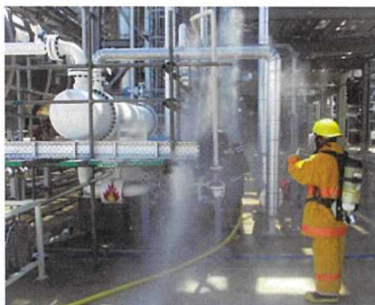
ทีมฉุกเฉิน เข้าปิดวาล์วเพื่อหยุดการรั่วไหล
